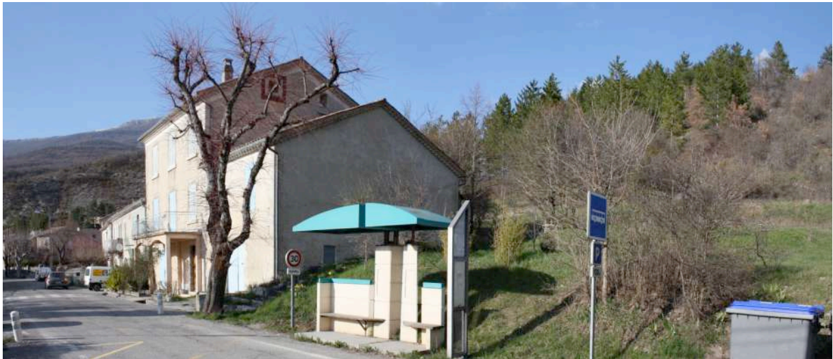
Vue rapprochée du site depuis le Sud
